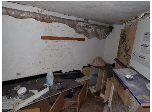
Kuva 6 Yleiskuva kellarikerroksen sisätiloista.
