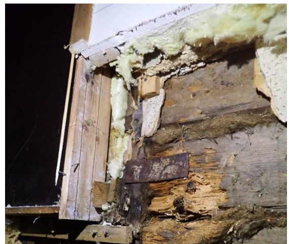
Kuvat 38 ja 39 Hirsiseinässä on lahovaurioita lähellä ikkunaliittymää takkahuoneessa 101. Ulkoseinän rakennetyyppi on US1.
