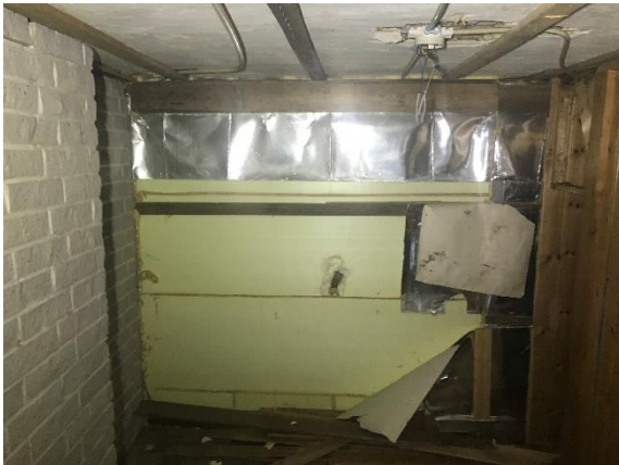
Kuva 22 Maanvastaisen seinän sisäpuolella paikoin PU-eristelevy (tila 001).
