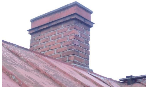
Kuva 63 Yleiskuva vesikatolta, muurattu piippu, jonka päällä pellitys.
