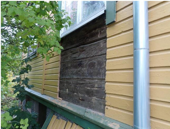
Kuva 36 Selkeenkujan puoleisen päädyn ulkoseinän rakenneavauskohta.
