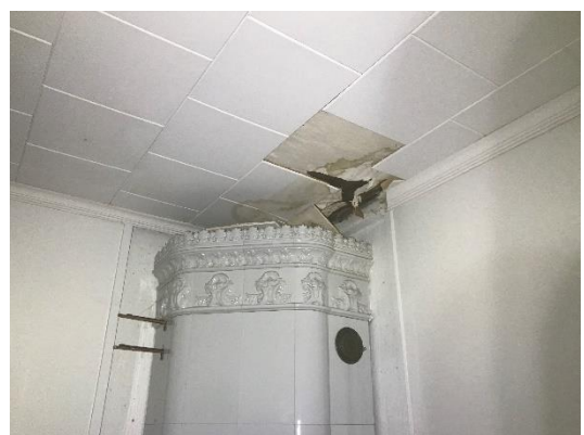
Kuva 8 Yleiskuva 1. kerroksen sisätiloista.
