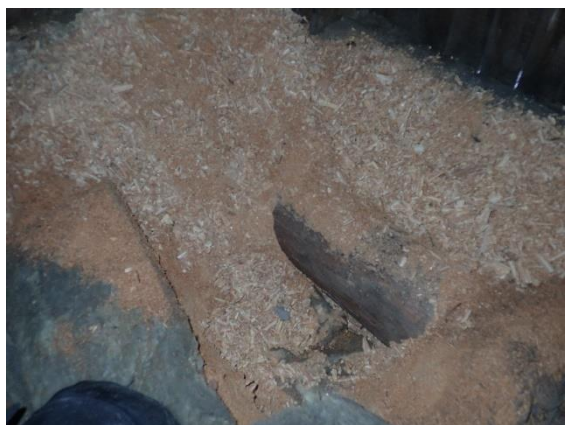
Kuva 73 Hirsirakenteen alapinnan kuntoa tutkittiin tarkemmin aistinvaraisesti. Hirren alaosan kunnossa ei todettu puutteita.
