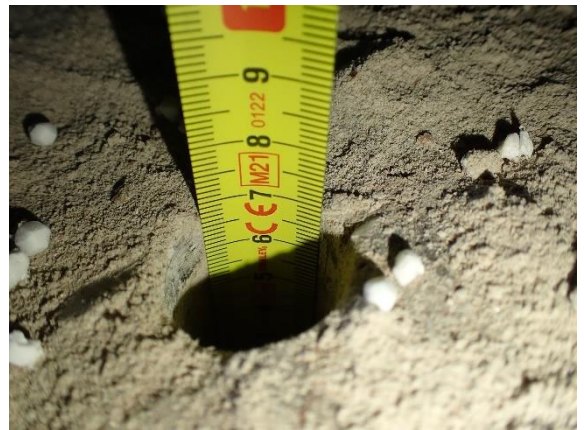
Kuva 30 Alapohjarakenne AP2, pintabetonilaatta n. 70 mm, jonka alla todettiin EPS-eriste.
