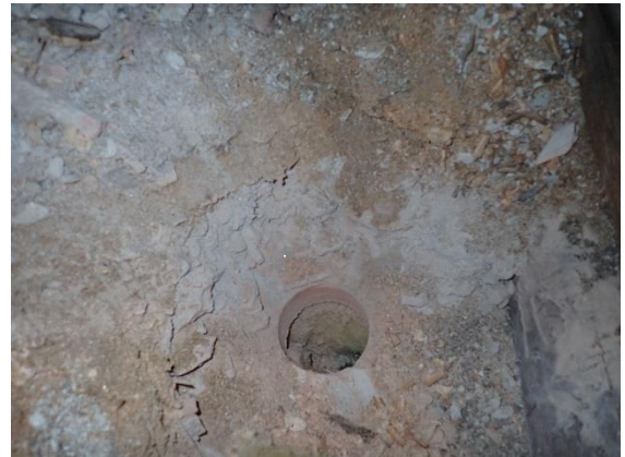
Kuva 75 Yläpohjan rakenneavauskohdassa eristekerroksen jälkeen tulee laudoitus, puukuitulevy, mineraalivilla ja muovikalvo.
