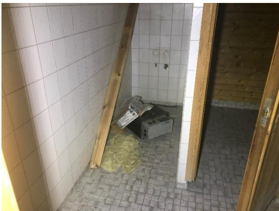
Kuva 20 Kellarin pesuhuone- ja saunatiloissa maanvastaiset seinät olivat levytettyjä ja niissä on lisälämmöneristys (tilat 005 ja 006).
