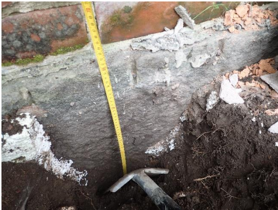
Kuva 16 Sokkelissa graniittimuuraus.
