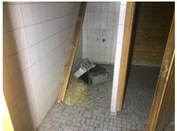
Kuva 28 Yleiskuva tiloista 005/006, tiloissa on laatoitus (AP1).
