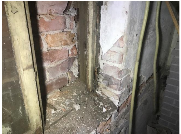
Kuva 25 Kellarikerroksen ikkuna-aukkoja on ummistettu muuraamalla ja/tai levyttämällä (tila 002).
