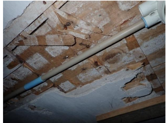
Kuva 51 Kellaritiloissa välipohjan laudoituksen alapinnassa on pääsääntöisesti tikutusrappaus.
