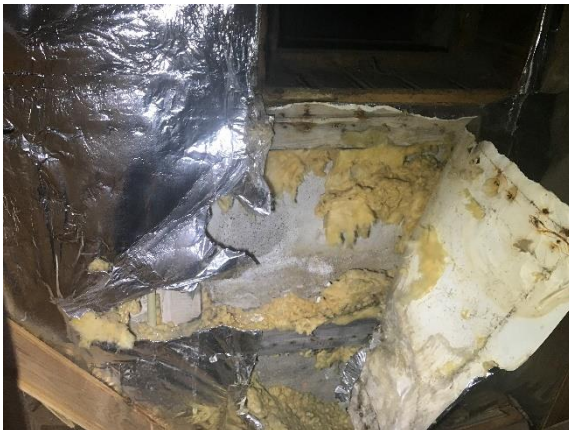
Kuva 24 Maanvastaisen seinän sisäpuolella paikoin mi- neraalivillaeriste.
