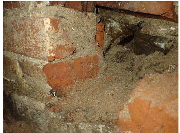
Kuva 19 Sisäpuolisen tiilimuurauksen takana kivilatomus (tila 007).
