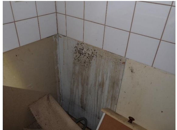
Kuva 59 Mikrobikasvua levypinnalla (tila 107).
