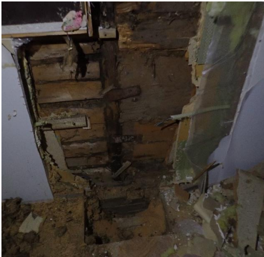
Kuva 54 Takkahuoneen 101 välipohjan (VP3) rakenneavaus tehtiin lähelle ulkoseinää.
