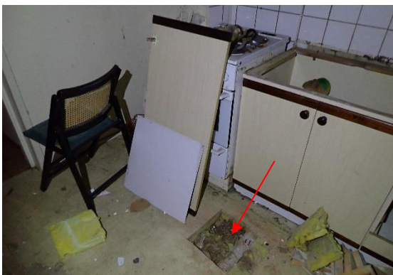
Kuva 52 Keittiön 107 välipohjan (VP2) rakenneavaus-kohta.
