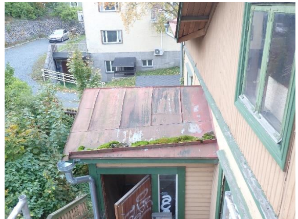
Kuva 61 Kuiastien päällä myös peltikate.
