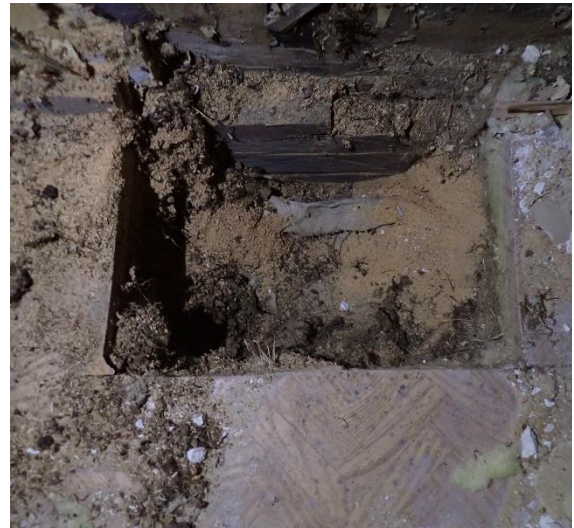
Kuva 55 Takkahuoneen välipohjan (VP3) eristetila sisältää mineraalivillaa, pellavarivettä, sahanpurua ja turvetta.
