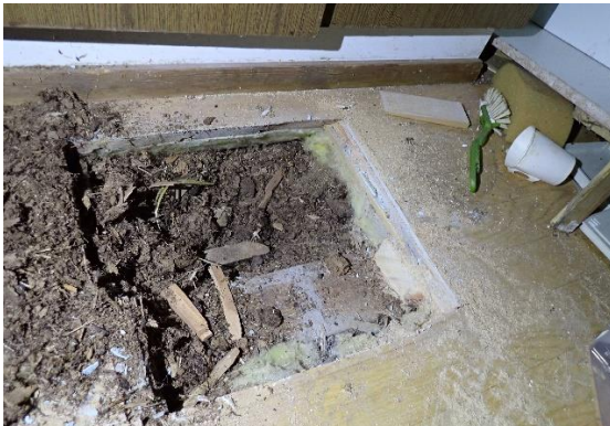
Kuva 48 Keittiön 110 välipohjan (VP1) rakenneavaus-kohta.
