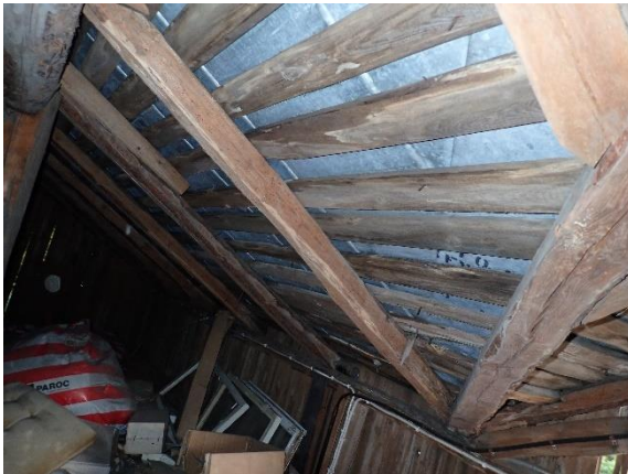
Kuva 62 Peltikatteen alla ei ole aluskatetta.
