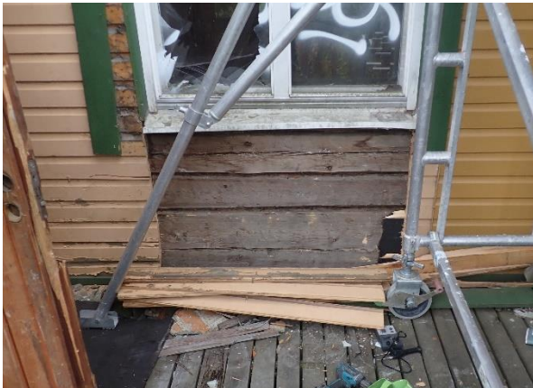
Kuva 34 Sisäpihan puoleisen julkisivun ulkoseinän rakenneavauskohta. Lautaverhouksen ja tervapaperin takana on hirsirunko. Yläpuoleinen ikkuna on rikki.
