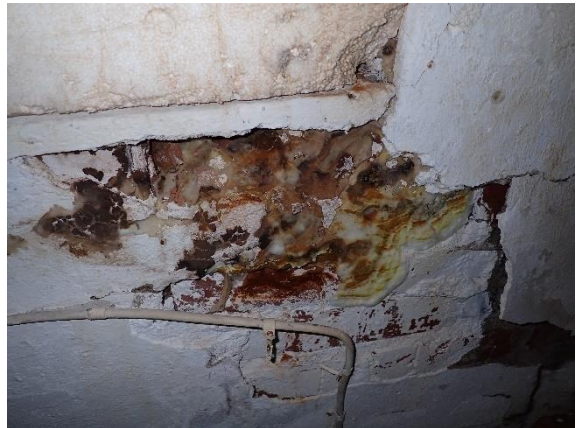
Kuva 23 Maanvastaisen seinän sisäpinnalla paikoin run- sasta sienikasvustoa, kuvassa oletettu lattia- sieni (tila 001).
