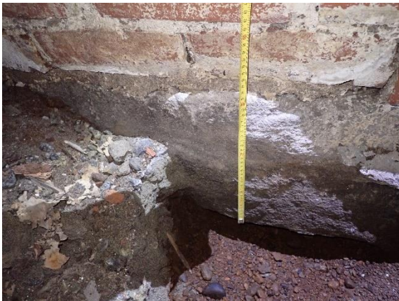
Kuva 18 Kellarin rakenneavaus, anturana on graniittilohkareita, joiden päällä tiilimuuraus (tila 007).
