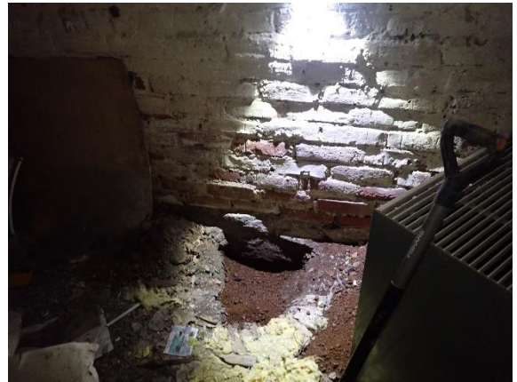
Kuva 17 Maanvastaisten seinien sisäpuolella on useissa tiloissa paljas tiilipinta.
