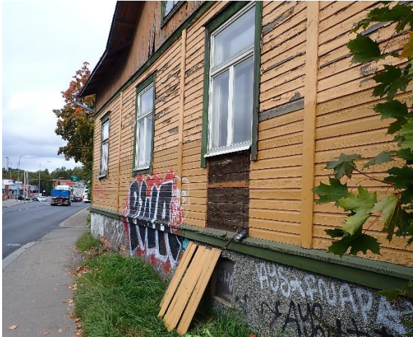
Kuva 32 Yleiskuvaa Pispalan valtatie puoleisen julkisivun ulkoseinän rakenneavauskohdasta. Lautaverhouksen ja tervapaperin takana on hirsirunko.
