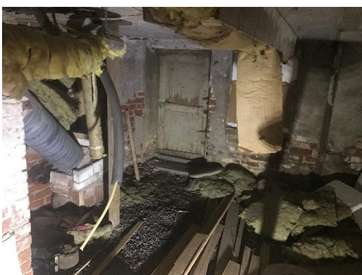
Kuva 7 Yleiskuva kellarikerroksen sisätiloista.
