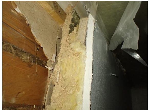
Kuva 43 Yleiskuva, ulkoseinärakenne US1.
