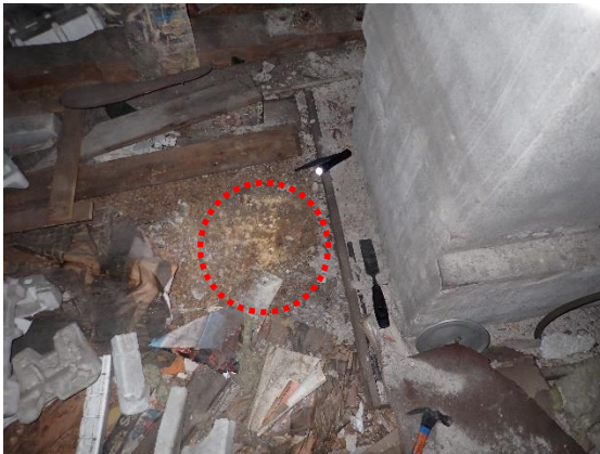
Kuva 74 Yläpohjaan rakenneavaus lähellä hormia.
